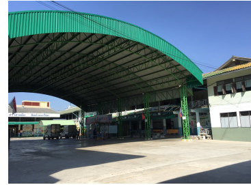
ภาพที่ 4 การใช้โครงสร้างหลังคาคลุมพื้นที่ผิวคอนกรีต
