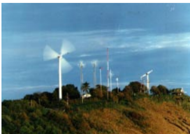
รูปที่ 4 สถานีผลิตไฟฟ้าจากพลังงานทดแทนของการไฟฟ้าฝ่ายผลิต แหลมพรหมเทพ จังหวัดภูเก็ต (Siripuekpong et al., 2002)
