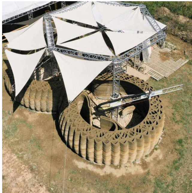
รูปที่ 5 การใช้เทคโนโลยีการพิมพ์สามมิติในการก่อสร้างบ้าน ในประเทศอิตาลี ในปี ค.ศ.2021 ที่มา: https://www.3dwasp.com/en/3d-printed-house-tecla/
