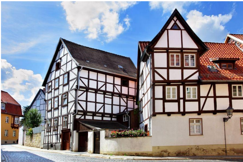
รูปที่ 7 การใช้โครงสร้างไม้ผสมกับดินในการสร้างบ้านที่ประเทศโปแลนด์
