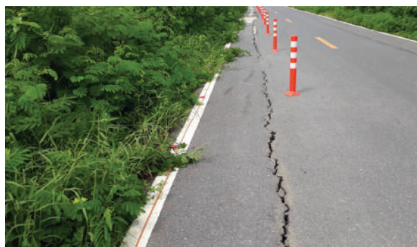
(ค) ลักษณะการทรุดตัวบริเวณไหล่ทางด้านซ้าย
