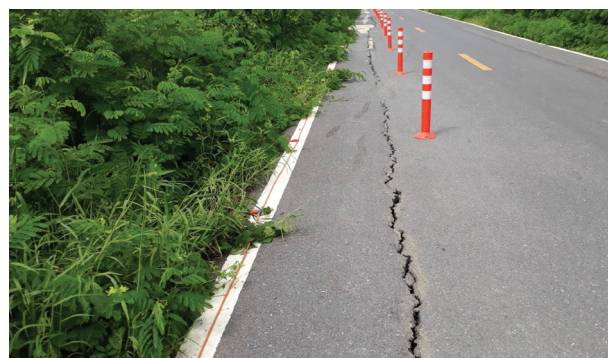
(ค) ลักษณะการทรุดตัวบริเวณไหล่ทางด้านซ้าย
