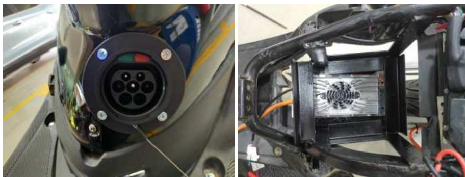
ภาพที่ 2 ตำแหน่งติดตั้งหัวชาร์จ type 2 และ On-board Charger OBC
