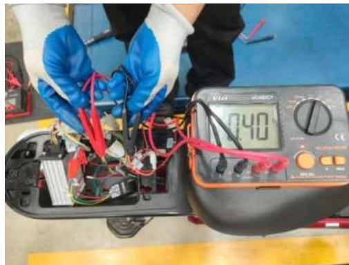
ภาพ 4.3 การวัดความต้านทานขอลวดมอเตอร์ใช้เครื่อง Milliohm Meter
