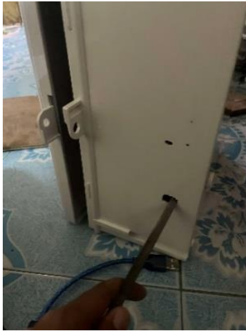
รูปที่ 25 การเชื่อมต่อสายไฟผ่านรูที่ได้เจาะไว้
