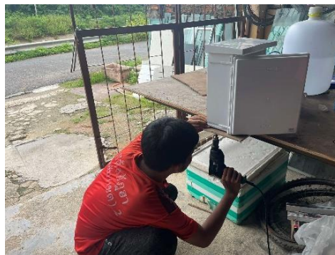
รูปที่ 23 การยึดตู้ไฟกันน้ำเข้ากับไม้กระดาน
