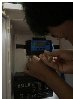
รูปที่ 24 การติดตั้งอุปกรณ์ภายในตู้จดหมายอัจฉริยะ
