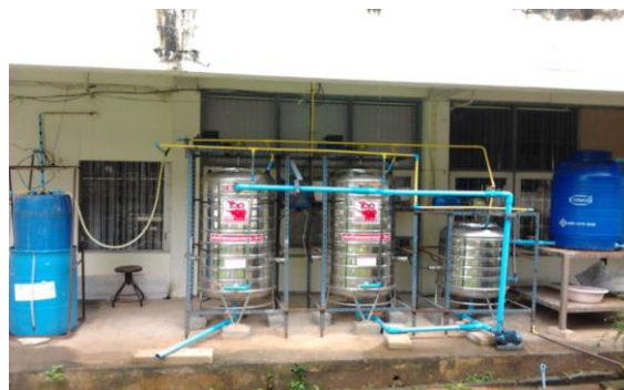
รูปที่ 2 ถังหมักก๊าซชีวภาพแบบสองขั้นตอน
