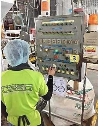
รูปที่ 3 การควบคุมการฉีดไอน้ำโดยพนักงาน
