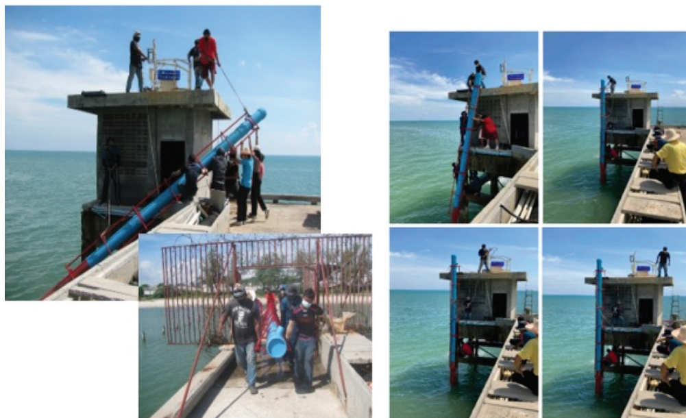
รูปที่ 7 การขนย้ายและการติดตั้งอุปกรณ์โพลดหั่ววัดรังสีได้น้ำทะเล
