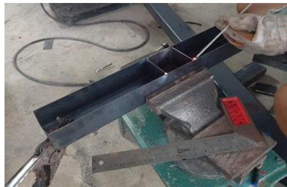
ภาพที่ 3 เชื่อมประกอบอุปกรณ์โครงสร้างรถเข็นสูบน้ำ
