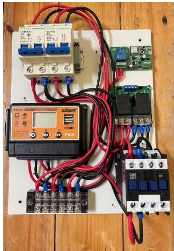
ภาพที่ 7 เดินสายอุปกรณ์ควบคุมไฟฟ้าและโซลาร์เซลล์
