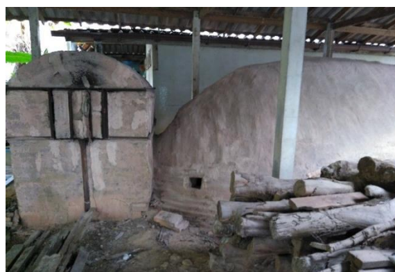
ภาพที่ 16 โครงสร้างช่องเติมเชื้อเพลิงเตาเผาไฟต่ำ
