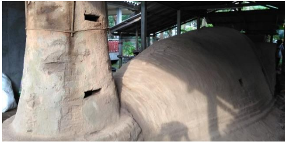
ภาพที่ 22 โครงสร้างปล่องไฟทางดินลมและห้องเผา ต้นแบบจากเตามังกรพื้นบ้าน (ธนบดี)
