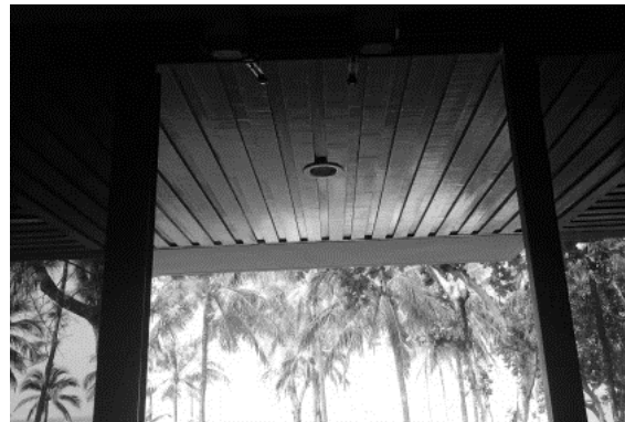
ภาพที่ 5 การติดตั้งอุปกรณ์อิเล็กทรอนิกส์ภายในห้องพักในขณะที่ปิดเปิดประตู
